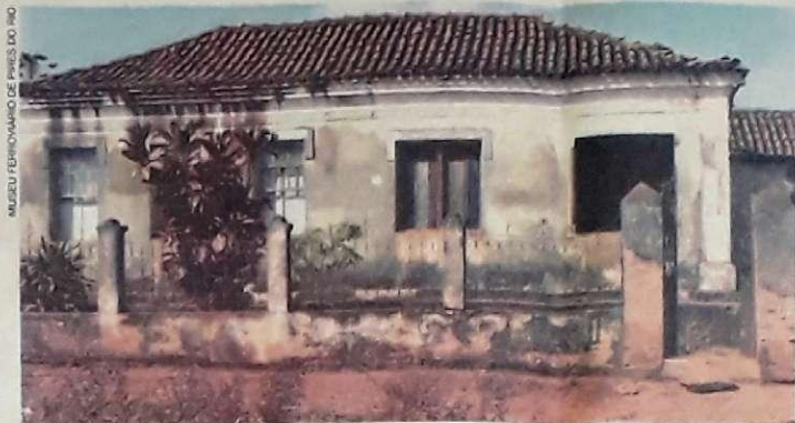
Foto de 1981 da primeira casa de alvenaria construída na cidade de Pires do Rio, 1923, pelo coronel Manoel Cavalcanti Nogueira
